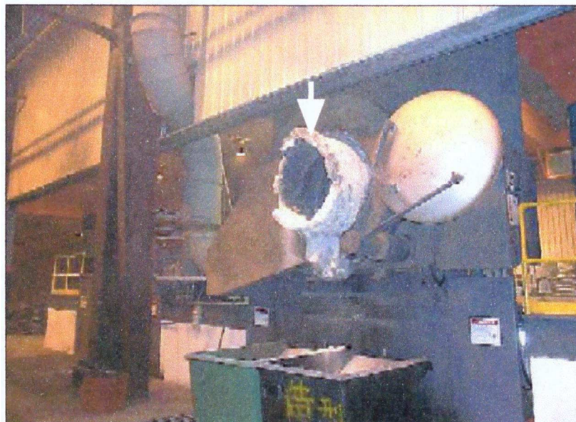
圖 30 爐襯推出情形 (箭頭指示)
