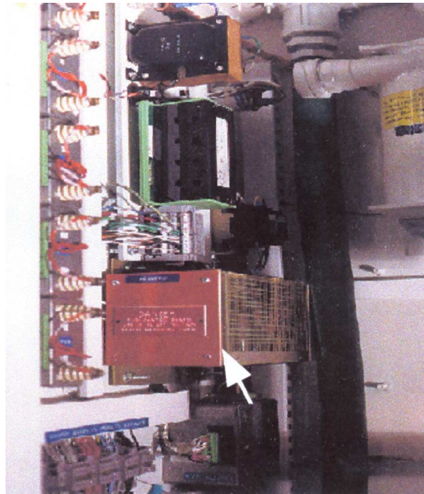
圖 15 直流電源供應器（箭頭指示）
