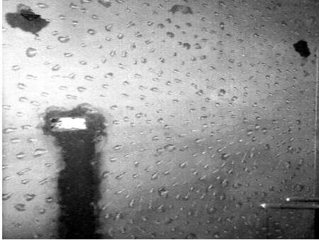
圖 16 舊有粉刷面打毛重新粉刷
