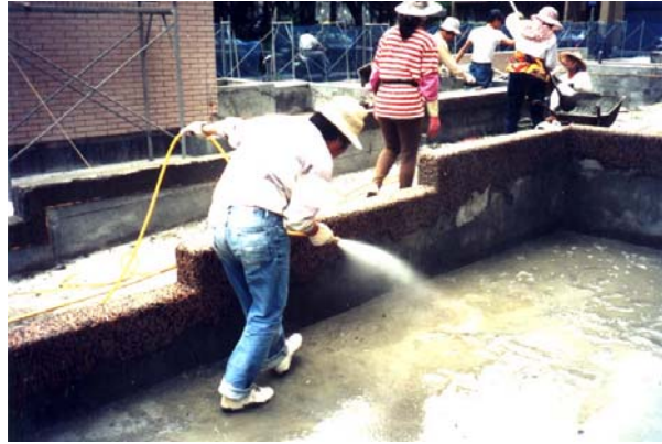
圖 3 沖洗場地的水帶有水泥漿
