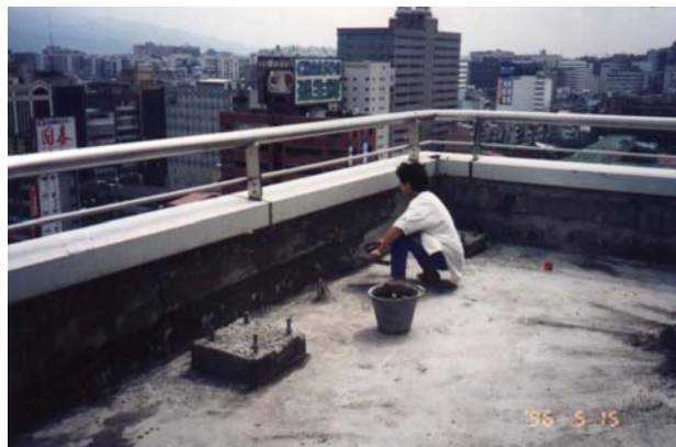
圖 1 女兒牆粉刷施工
