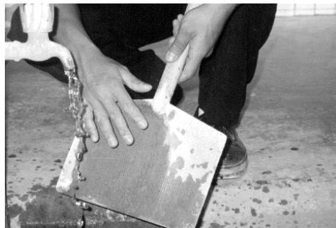
圖 4 清洗沾滿水泥砂漿的工具 水不可直接流入排水溝
