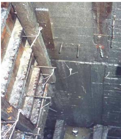
圖 14 混凝土牆拆模後 牆上雜物應該先清除
