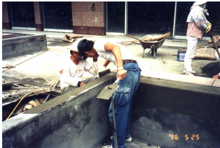
粉刷工程進行中，施工人員要相互配合
