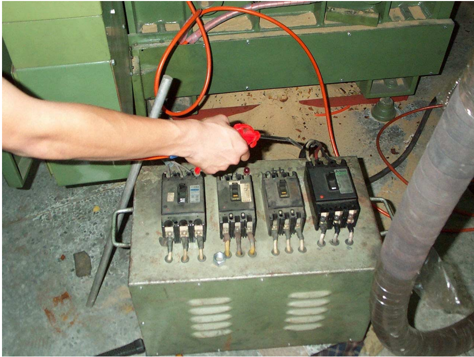
圖 21 清除開關落砂及灰塵
